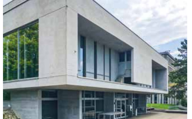
Das Aulagebäude aus Südwesten. Gut zu sehen ist die in die Südfassade integrierte Filmkabine.
